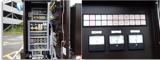
排水ポンプ制御盤設置状況
