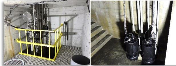
排水ポンプ及び配管設置状況
