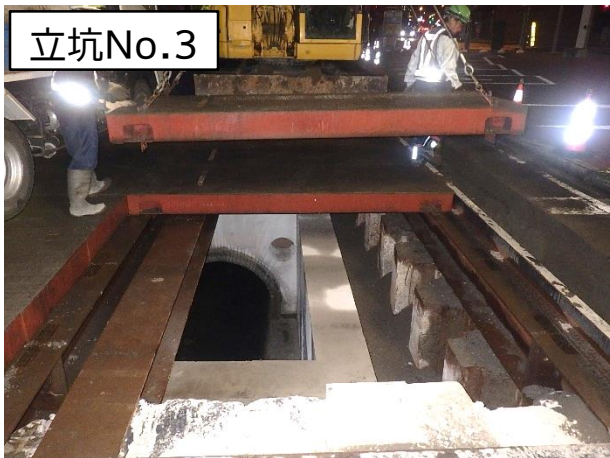
覆工板撤去状況
