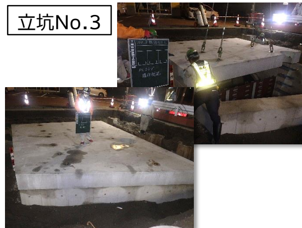
特殊(分水)人孔築造状況
