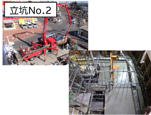
特殊人孔築造(コンクリート打設)状況
