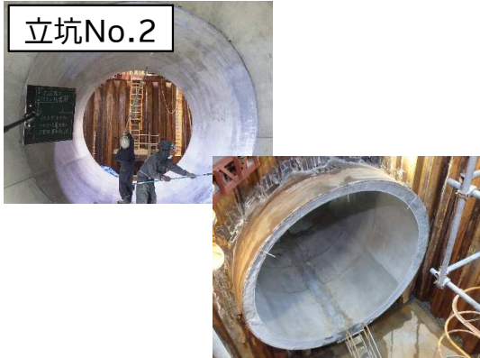
シールド掘進機外殻残置箇所仕上げ状況
