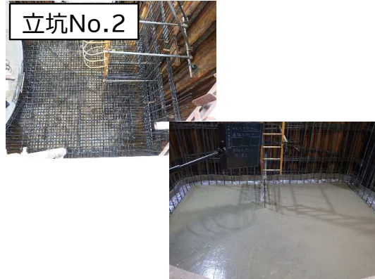
特殊人孔築造(配筋・底板コンクリート工)状況
