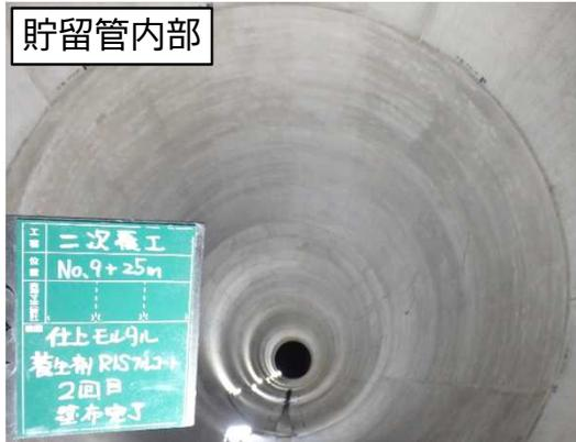
鋼製セグメント二次覆工(仕上げ)状況
