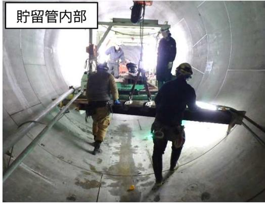
シールド工に係る軌条設備撤去状況
