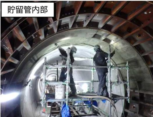
鋼製セグメント二次覆工(特殊充填材外吹付け)状況
