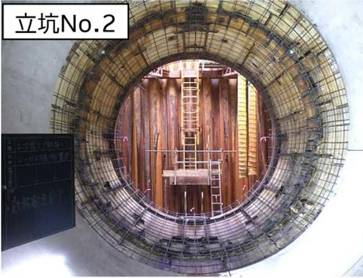
シールド掘進機外殻残置(配筋完了)状況
