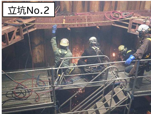
シールド掘進機の到達(鋼矢板切断)状況
