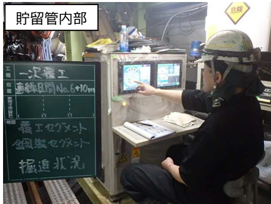
シールド掘進機による掘進状況(掘進機の操作管理)
