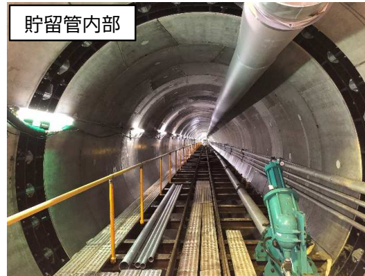
シールド掘進機による掘進状況(セグメント設置完了)
