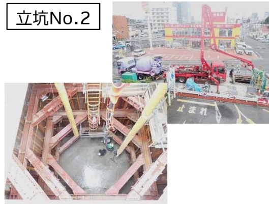
底盤コンクリート打設状況
