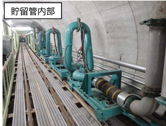
段取替え作業完了状況
