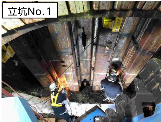
鏡切(鋼矢板壁撤去)状況
