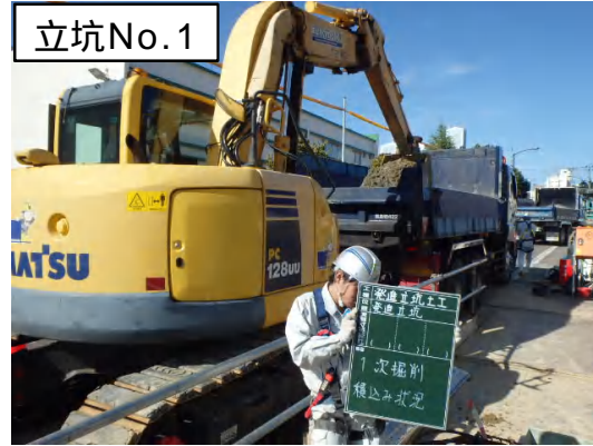
掘削残土積込状況
