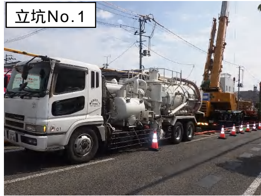
地盤改良(汚泥回収)状況
