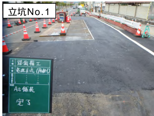
覆工板設置(舗装仮復旧)状況
