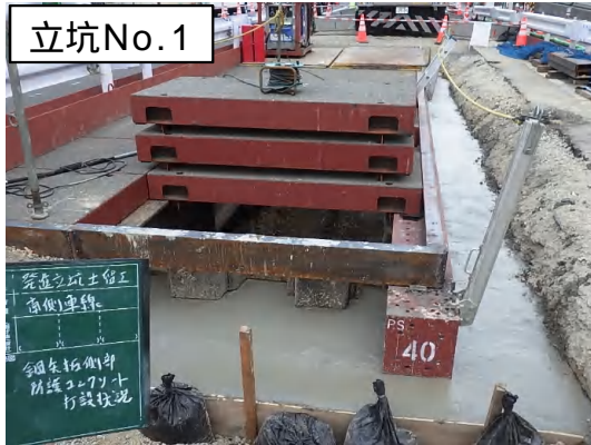
仮設土留(コンクリート防護)設置状況
