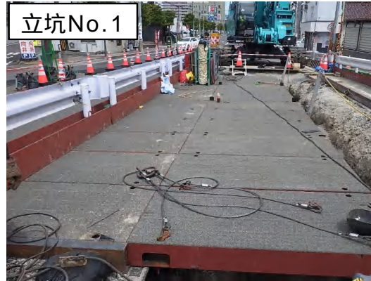
覆工板設置状況
