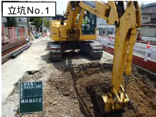
覆工板設置(路面掘削)状況
