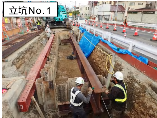
覆工板(受桁)設置状況
