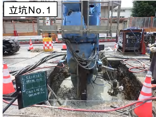
仮設土留(鋼矢板設置)状況
