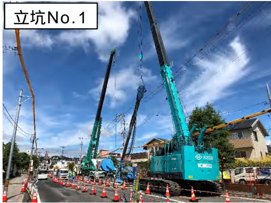
仮設土留(鋼矢板設置)状況
