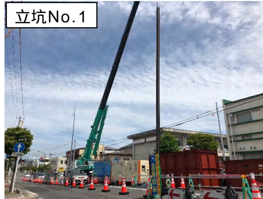
仮設土留(鋼矢板設置)状況
