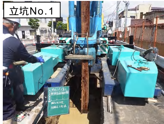
仮設土留(鋼矢板設置)状況
