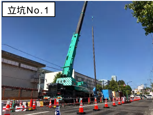
仮設土留(鋼矢板設置)状況
