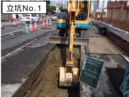
仮設土留(掘削)状況
