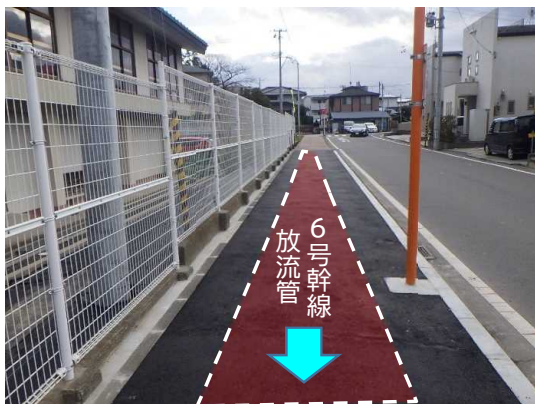
舗装仮復旧状況
