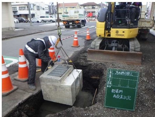
道路附属物復旧(街渠柵)状況
