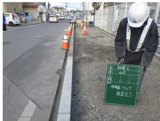
道路附属物復旧(歩車道境界ブロック)状況
