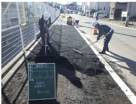
歩道部の舗装仮復旧状況
