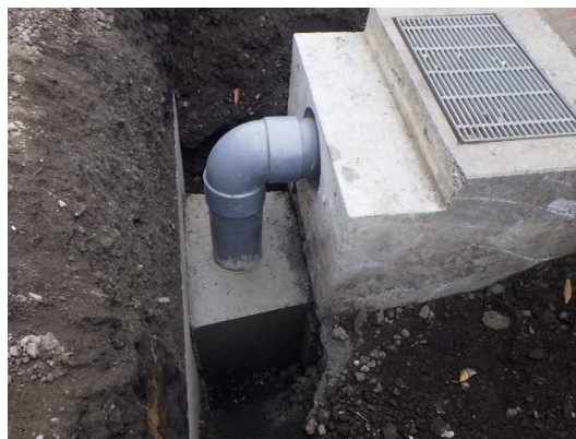
道路附属物復旧(街渠柵接続完了)状況
