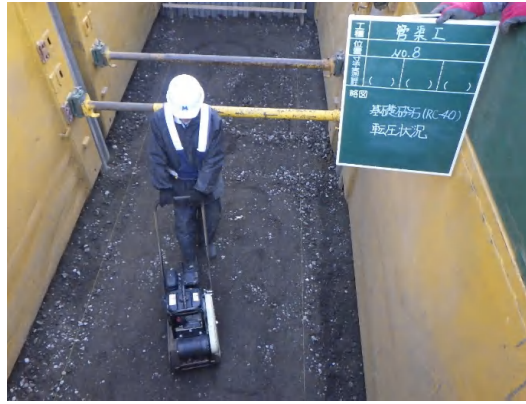
基礎工(砕石)状況
