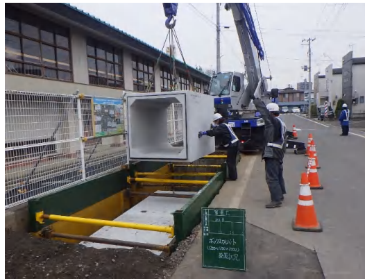
ボックスカルバート布設状況
