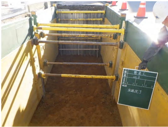
掘削・支保工状況
