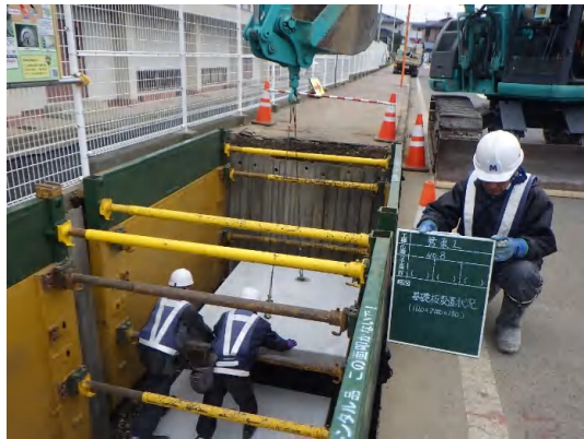
基礎工(コンクリート板設置)状況
