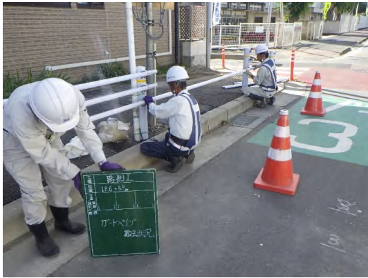
道路附属物(ガードパイプ)撤去状況
