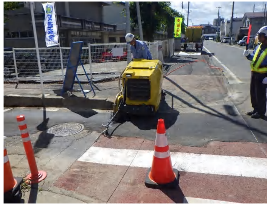
舗装取壊し(切断)状況
