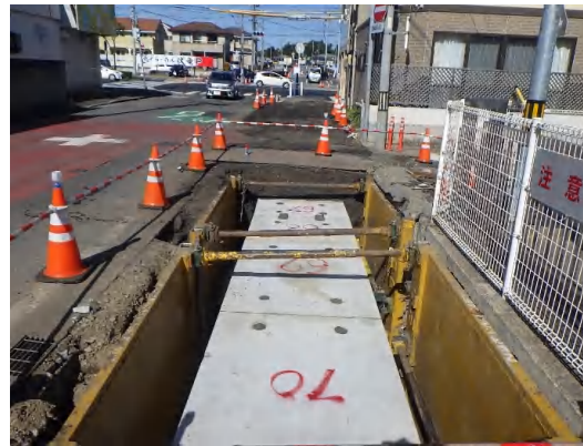
ボックスカルバート布設状況
