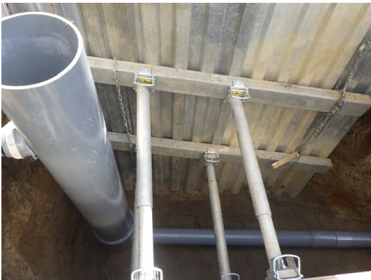
支障物(汚水管)移設状況
