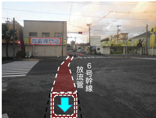
舗装本復旧状況(下流側から上流側を望む)
