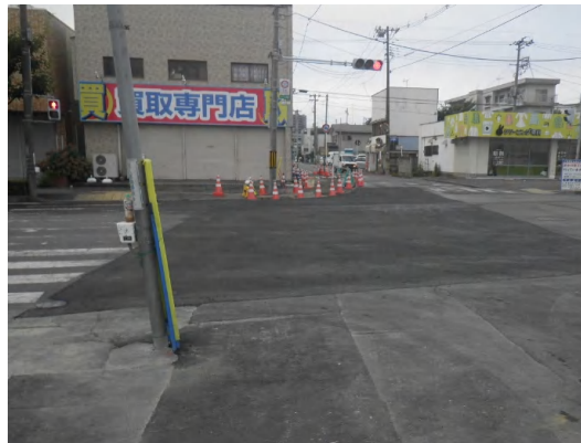
舗装仮復旧状況
