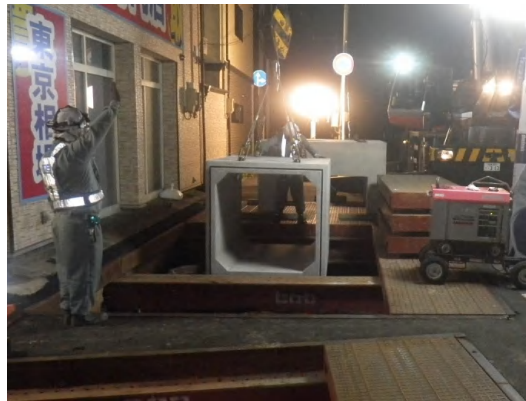
ボックスカバート布設状況
