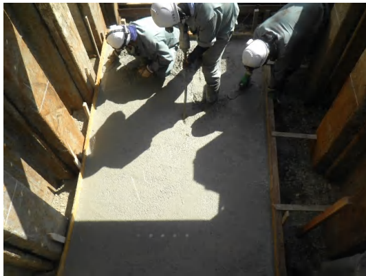
基礎工(コンクリート打設)状況
