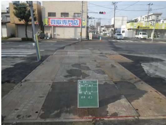
覆工板設置状況
