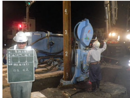
鋼矢板設置状況
