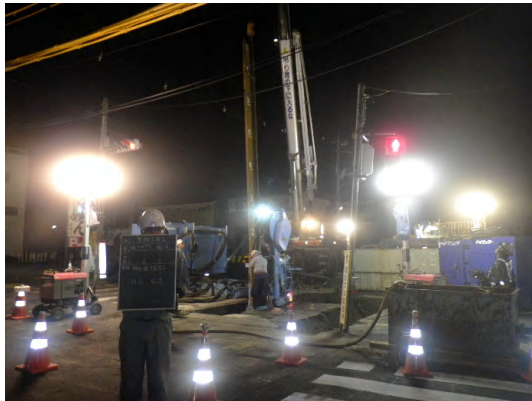
鋼矢板設置状況
