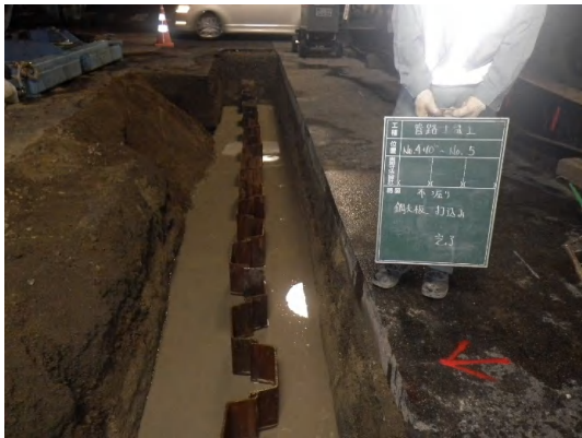
鋼矢板設置状況
