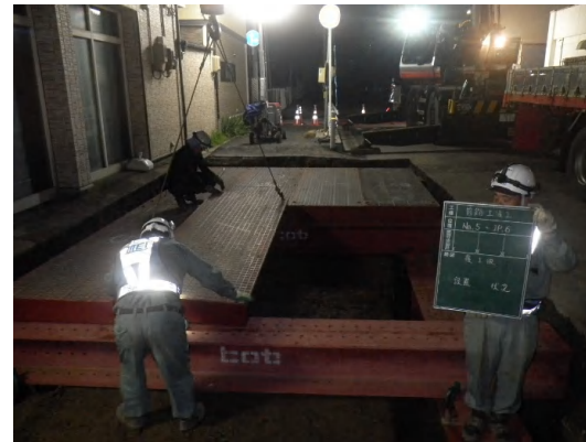
覆工板設置状況
