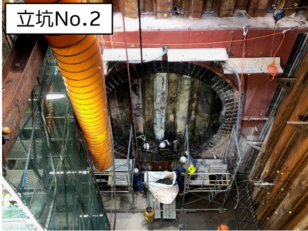
シールド掘進機の到達状況
