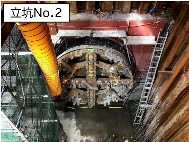
シールド掘進機の到達状況
