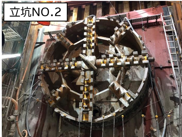
シールド掘進機の到達状況
