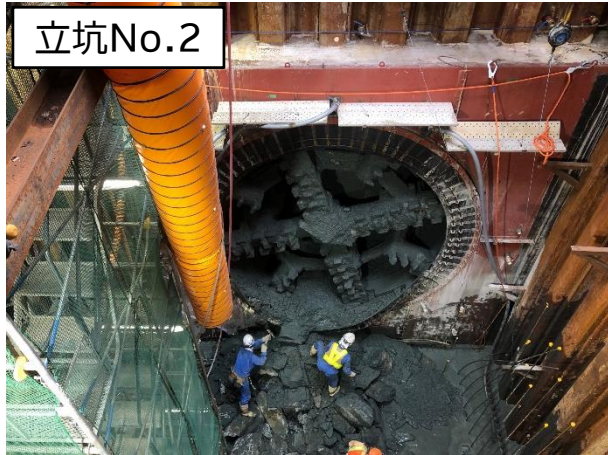
シールド掘進機の到達状況
