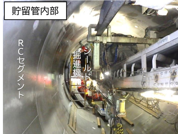
シールド掘進機による掘進状況
