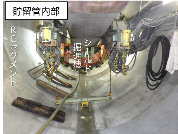
シールド掘進機による掘進状況
