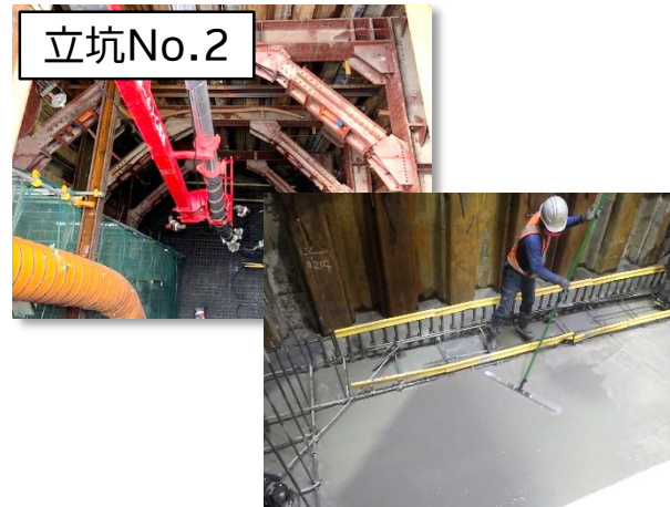
特殊人孔築造(コンクリートポンプ車打設)状況
