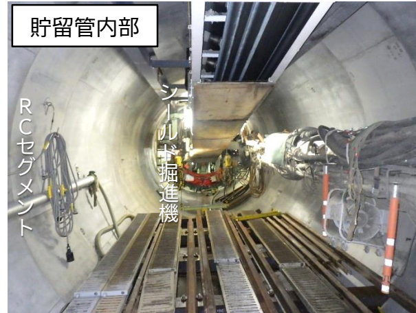
シールド掘進機による掘進状況
