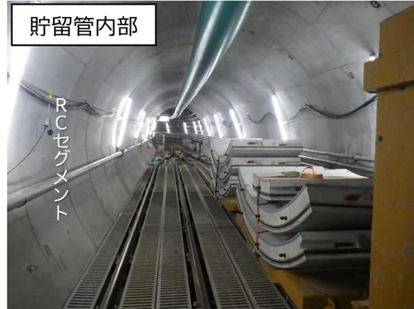
シールド掘進機による掘進(セグメント運搬)状況
