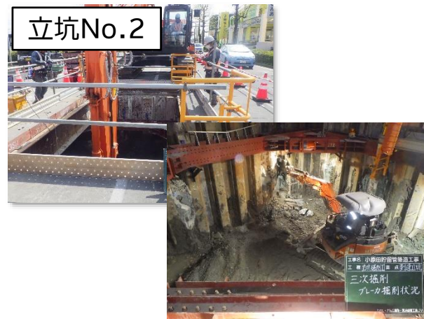
掘削・支保工状況
