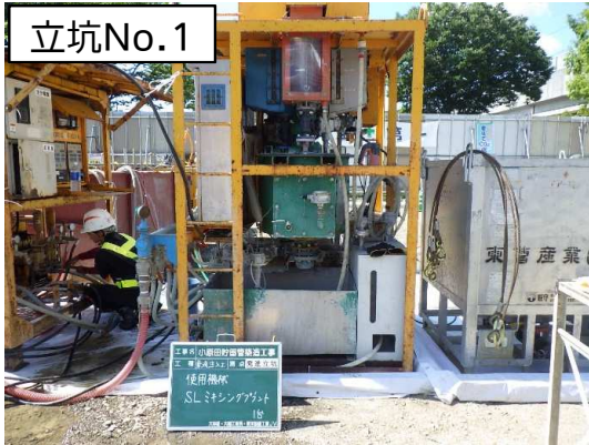
地盤改良状況(池田公園内)
