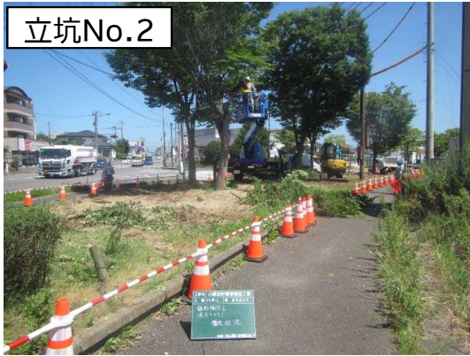
支障物撤去状況
