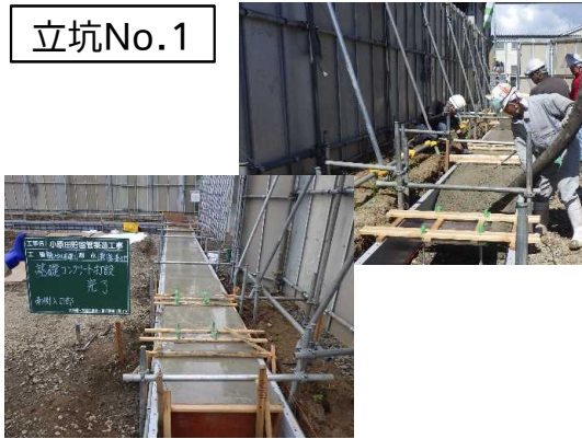
仮設防音ハウス基礎工(コンクリート打設)状況(池田公園内)
