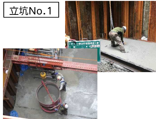
底盤コンクリート打設状況(池田公園内)
