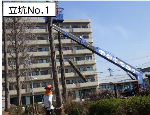
樹木撤去状況(池田公園内)
