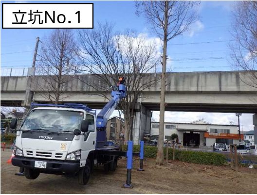
樹木撤去状況(池田公園内)
