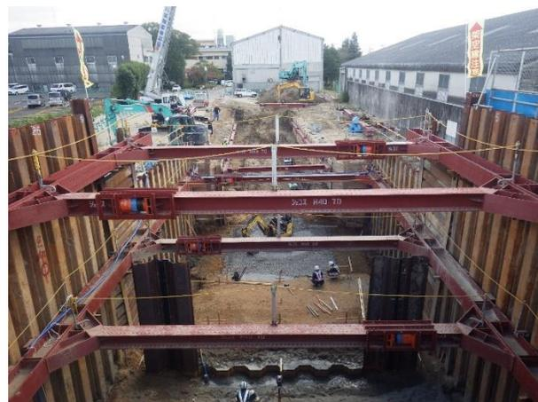
掘削・支保工状況(逢瀬川堤防より南側を望む)
