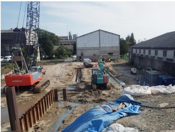
仮設土留(鋼矢板)設置状況(逢瀬川堤防より南側を望む)
