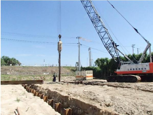
仮設土留(鋼矢板)設置状況(北側を望む)
