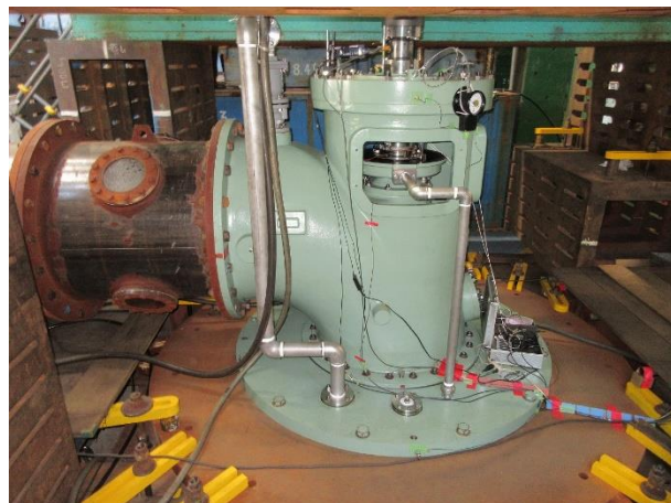
No.3雨水ポンプ本体 検査状況
