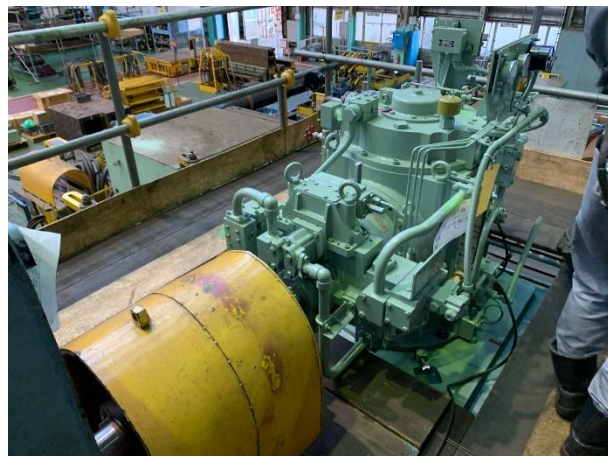
No.3減速機 検査状況
