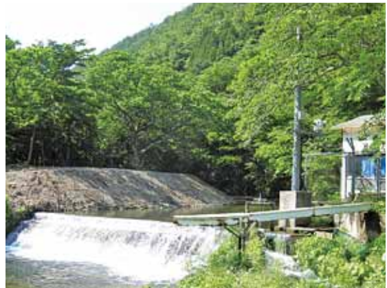
深沢川取水場
