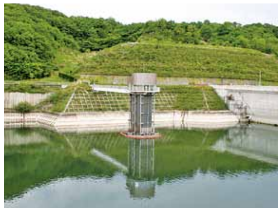
三春ダム取水塔
