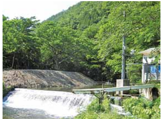
深沢川取水場
