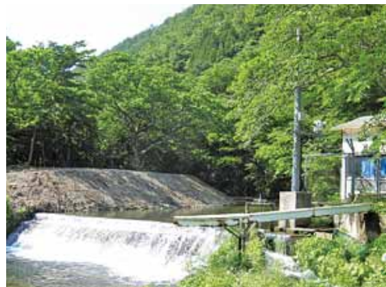
深沢川取水場
