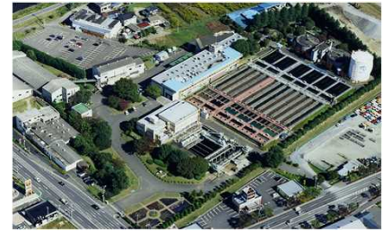
下水道管理センター
