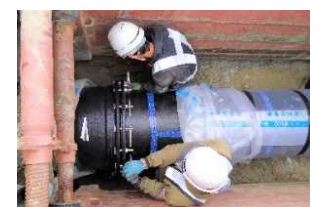
災害に強い水道管の布設
