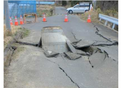
隆起したマンホール
