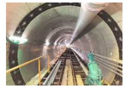
図景貯留管内部
