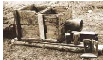
木管水道時代の木箱、木管、駒頭
