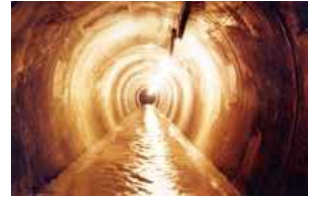
猪苗代湖からの導水ずい道
