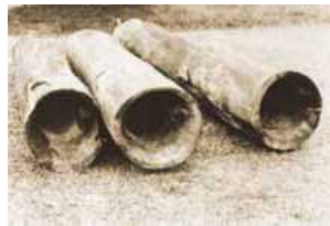
多田野水道木管
