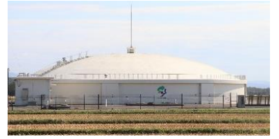
浄水場統合に伴い整備した多田野配水池
