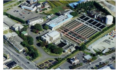
下水道管理センター
