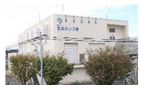
古川ポンプ場
