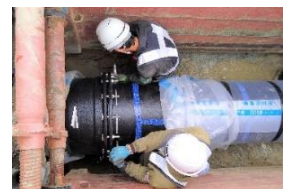
災害に強い水道管の布設
