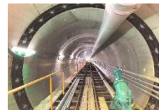
図景貯留管内部
