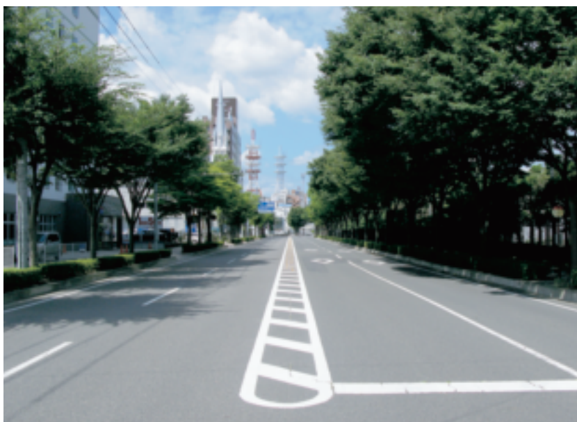
郡山駅東口へ通じる都市計画道路東部1号線（谷島町）
