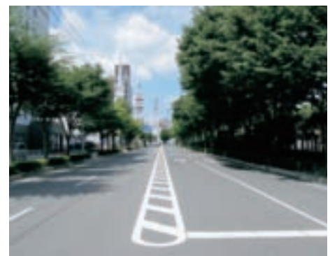
郡山駅東口へ通じる都市計画道路東部1号線（谷島町）
