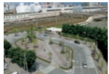
郡山駅東口広場
