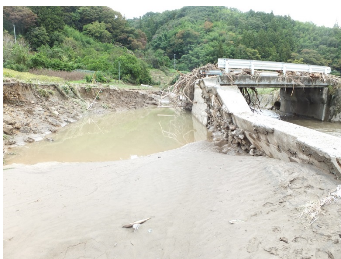
【二本松市寺坂橋】
