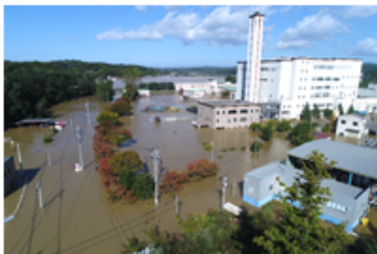
【富久山クリーンセンター及び衛生処理センター（郡山市）】 (2019年10月13日 株式会社スペースワン撮影)
