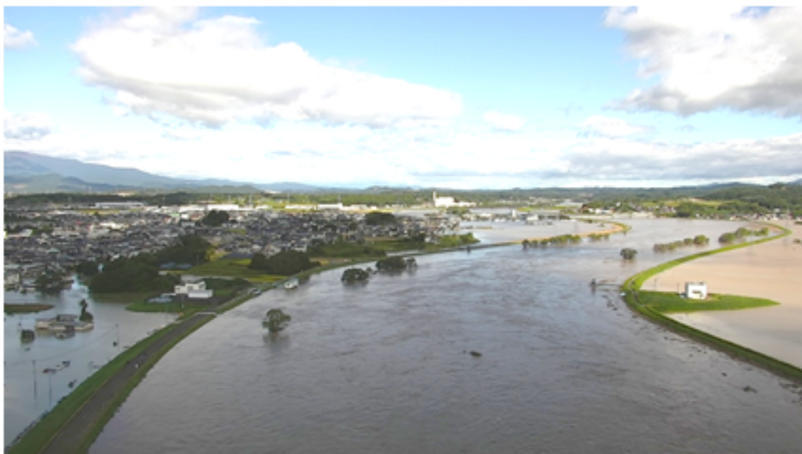
【氾濫した一級河川 阿武隈川（郡山市内）】 （2019年10月13日 株式会社スペースワン撮影）
