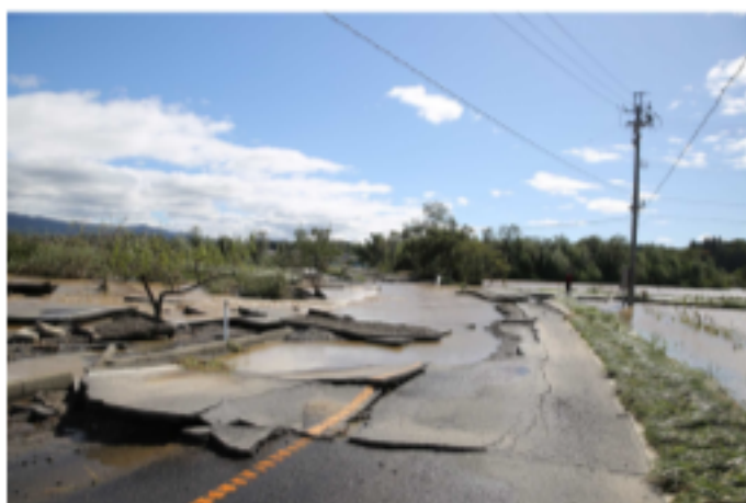
【須賀川市小作田橋】
