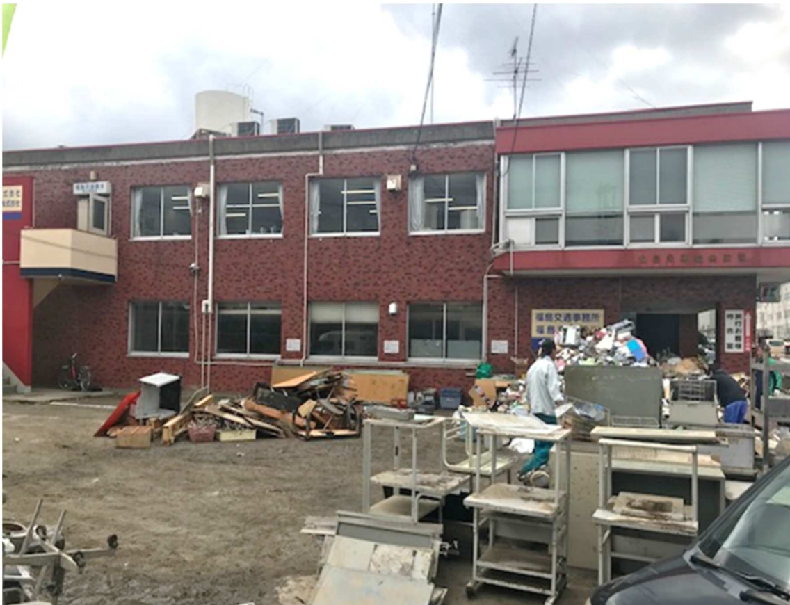
【バス被災状況（福島交通（株）郡山支社）】
