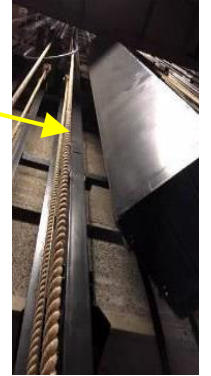
吊り物レール等破損
