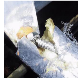
空調機冷温水配管破損
