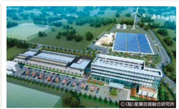
（独）産業技術総合研究所福島再生可能エネルギー研究所
