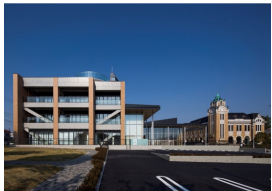
● 地中熱式空調設備を導入した「中央公民館」
