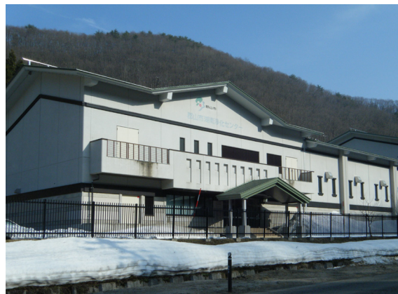
●湖南浄化センター
