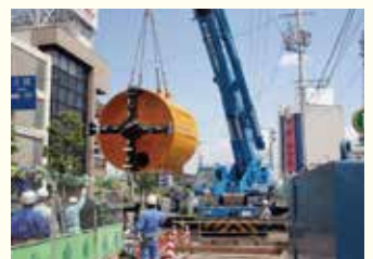
●雨水管の整備
