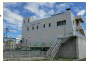
●古坦ポンプ場
