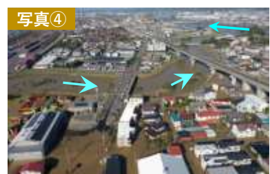
写真④ 笹原川・日出山付近 (10/13撮影 ㈱スペースワン提供)
