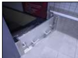
■止水板の設置補助
