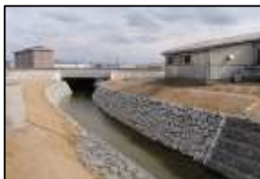
■雨水貯留施設等の整備
